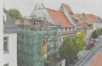
Die Burgstraße 38 erhält derzeit ein richtiges Dach und wird statisch gesichert. FOTO: ECKARDT MILDNER/ARCHIV
