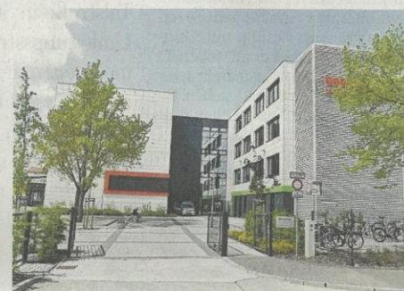
Die Mittelschule „Gottfried Pabst von Ohain“ ist für fast 11 Millionen Euro saniert und erweitert worden.
