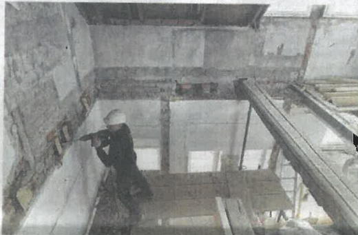
Vorarbeiter Ronny Pusch von der Firma Hoch- Tiefbau Mittwelda bereitet im Inneren die Stabilisierung des Gebäudes vor.
