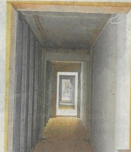
Im Inneren des Hauses Smaragd wurden neue Wände eingezogen und Barrierefreiheit geschaffen.
