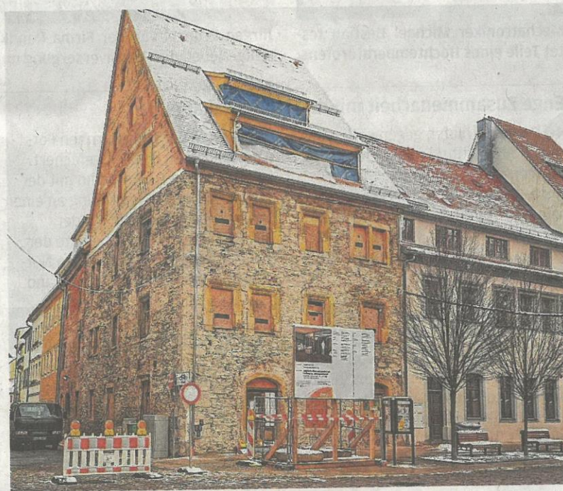
Nach dem Neuaufbau des Daches und dem Richtfest im Dezember 2020 ruht die Baustelle an der Burgstraße 38 für einige Wochen. Das Mauerwerk muss trocknen, bevor der Innenausbau beginnen kann.
