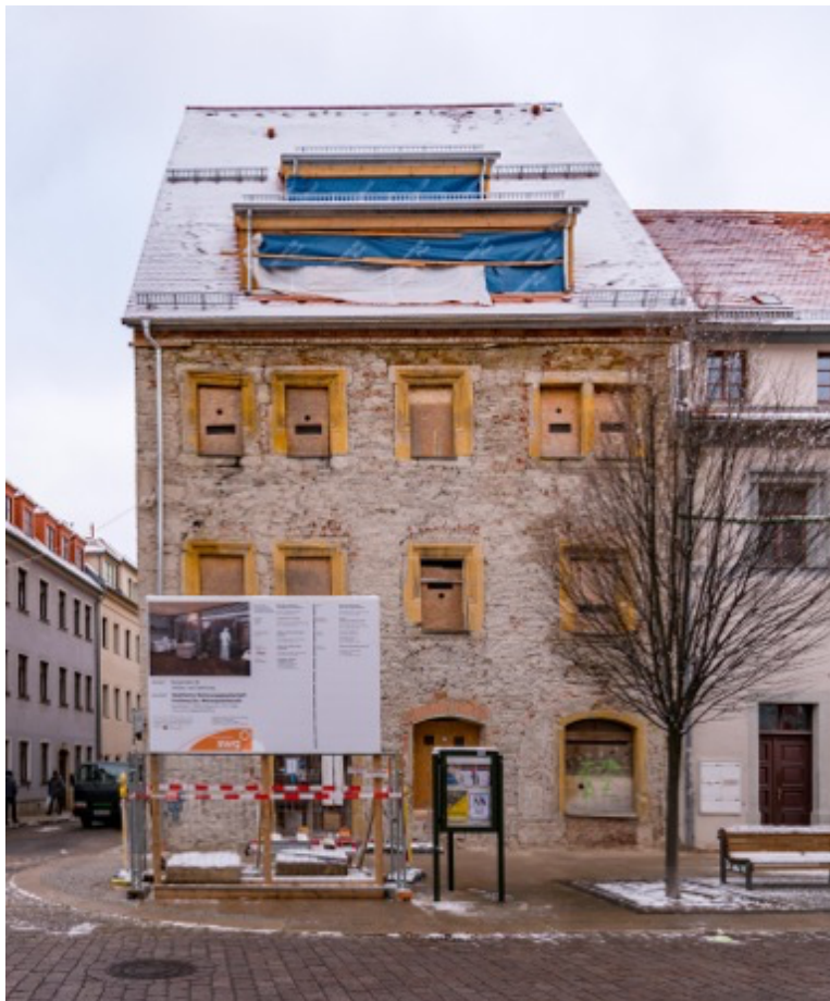
Das Baugerüst an der Burgstraße 38 wurde entfernt. Bis zur Fortsetzung der Sanierungsmaßnahmen im April 2021 muss das Mauerwerk des denkmalgeschützten Gebäudes erst noch weiter austrocknen. © SWG Freiberg
