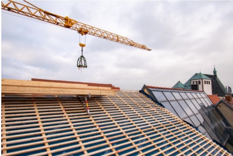
Die Zimmererarbeiten sind abgeschlossen, die Richtkrone schwebt über der Baustelle an der Burgstraße 38. Noch bis Weihnachten 2020 soll das Dach neu gedeckt sein, damit die Bausubstanz bis zum Frühjahr gut trocknen kann. © SWG Freiberg
