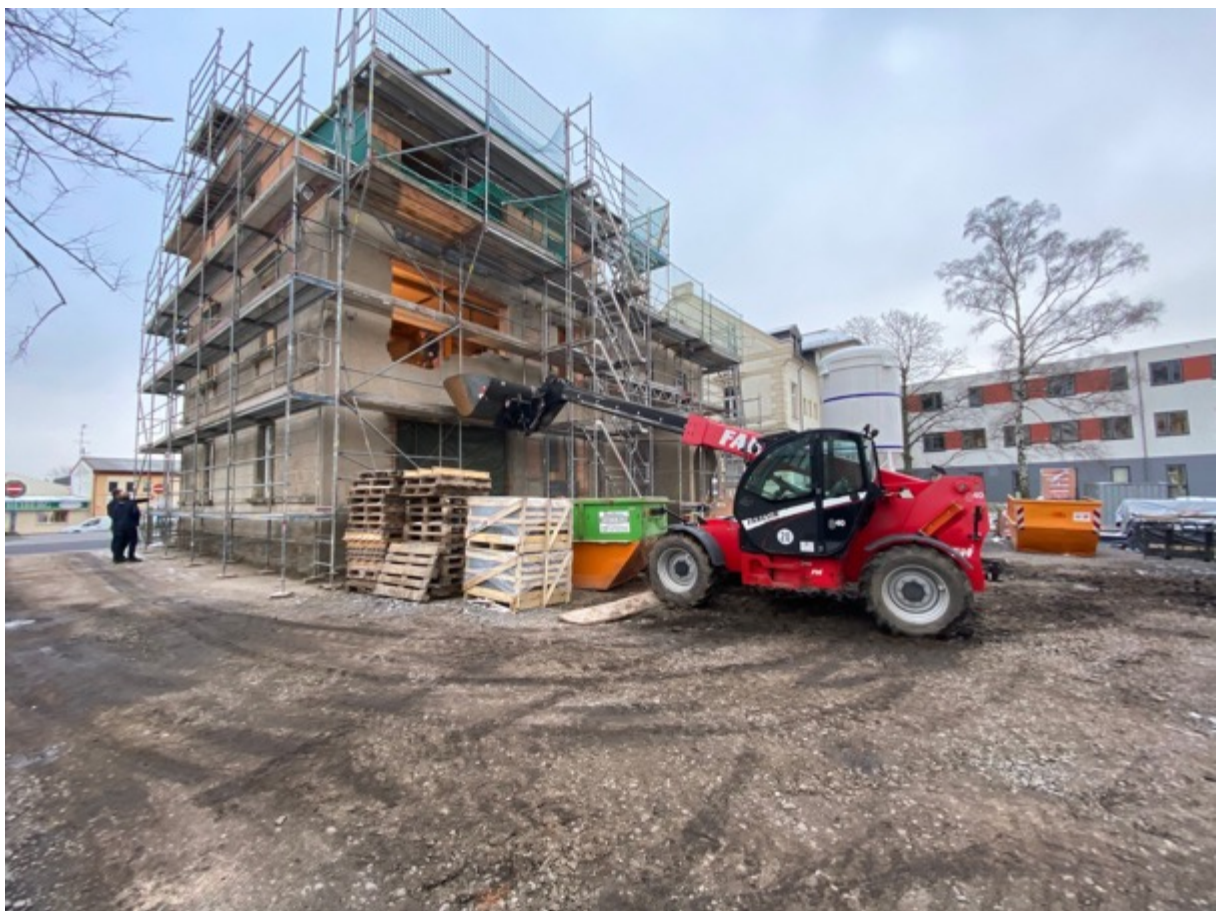
Die Sanierung der Stadtvilla Annaberger Straße 20 ist in vollem Gange. © SWG Freiberg
