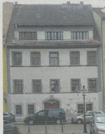
Das Haus Petriplatz 3 in Freiberg soll saniert werden. FOTO: STEFFEN JANKOWSKI
